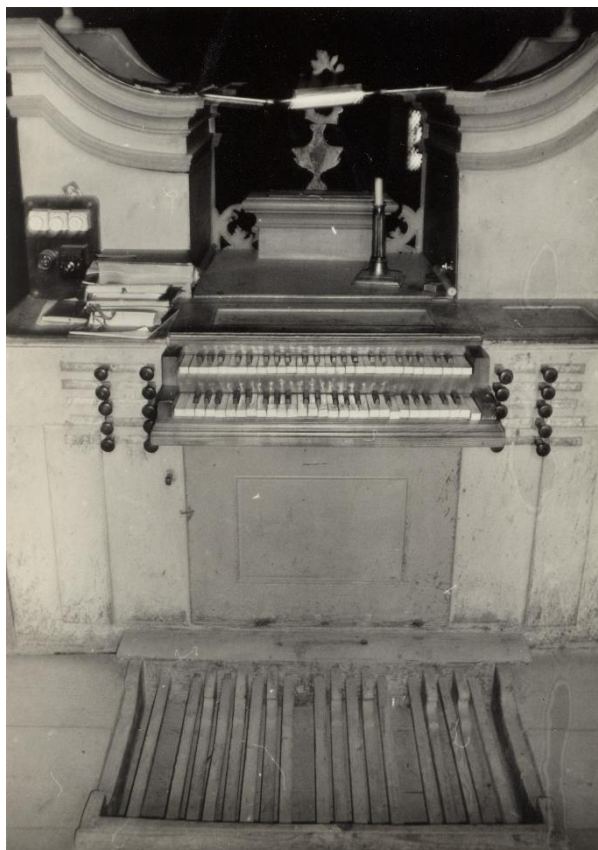
(54) Višňové, hrací stôl pred opravou (Rieger-Kloss), manuálové klaviatúry, pakne, registrové manubriá
