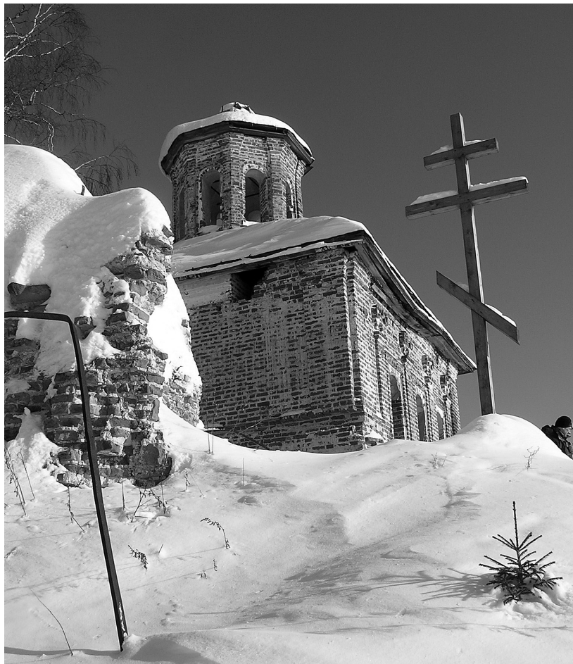
Sväto-trojický chrám čakajúci na rekonštrukciu v dedine Govorlivoe
