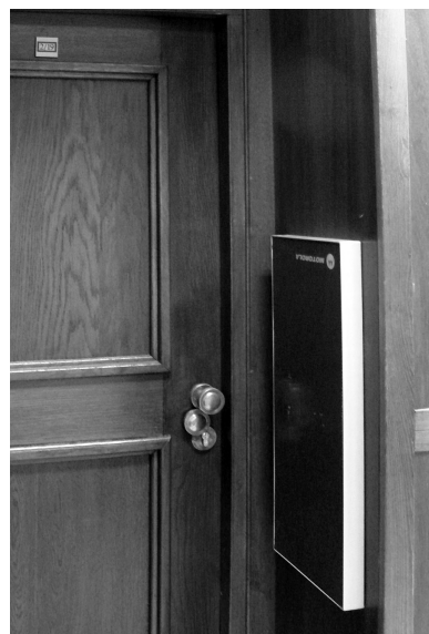
Obr. 3 RFID brána zabudovaná v zárubni dverí vedúcich do depozitára
